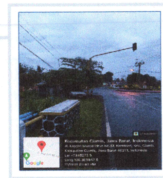
Lokasi Pemasangan Pipa JDU Ø 300 mm ( Jl. RSU - Jl. Kapt. Murod Idrus)
